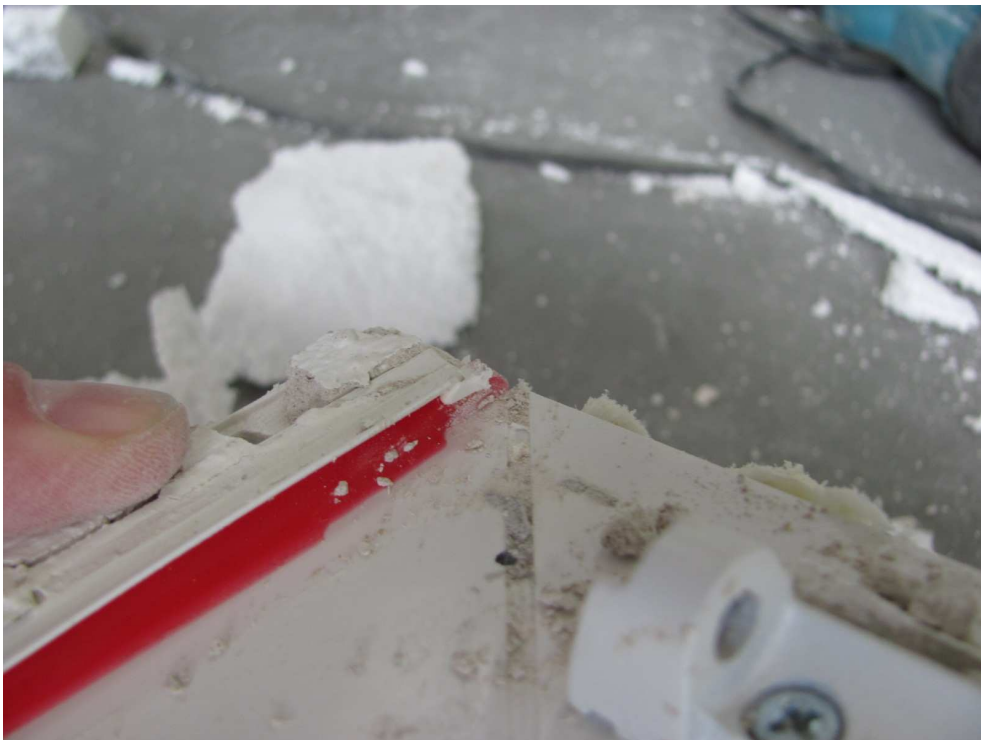
Bild 8 Demontierte Anputzdichtleiste T-FAL Dichtprofil 3761G
