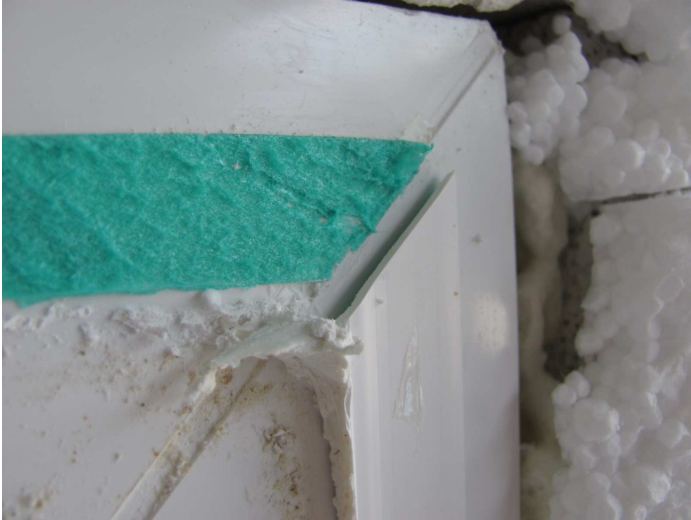
Bild 7 Demontierte Anputzdichtleiste T-FAL Dichtprofil 3779G
