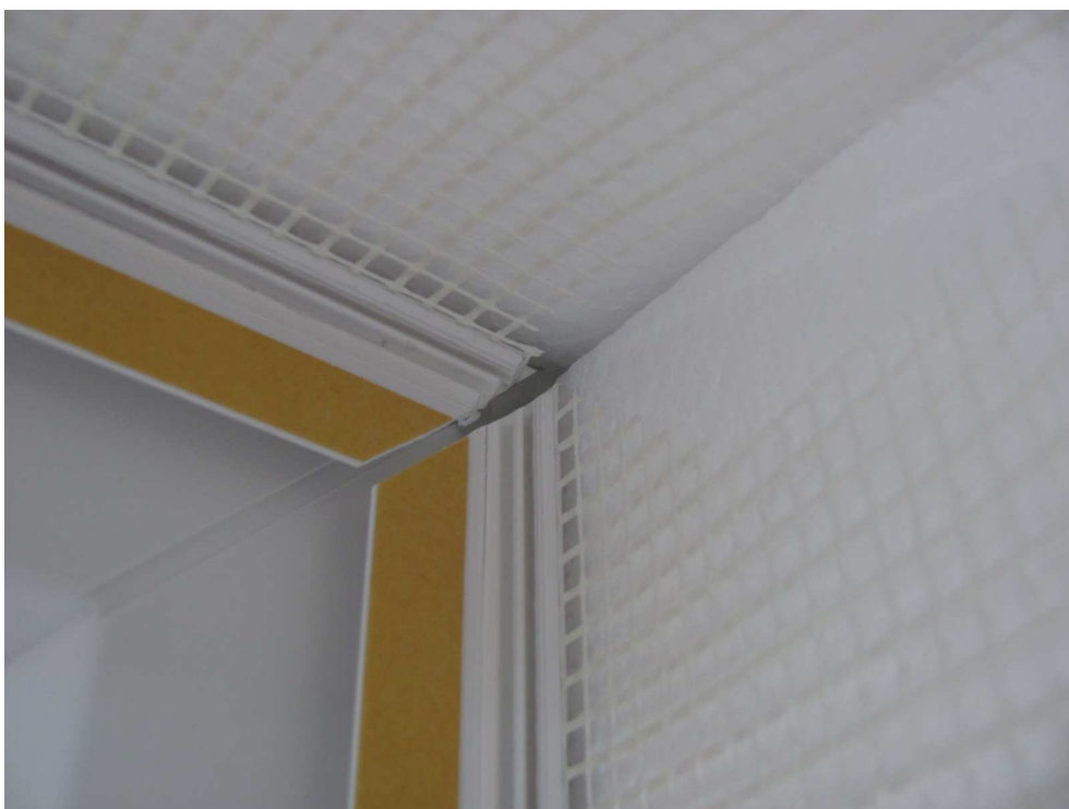
Bild 6 Detailansicht Gehrungsstoß mit Gelband
