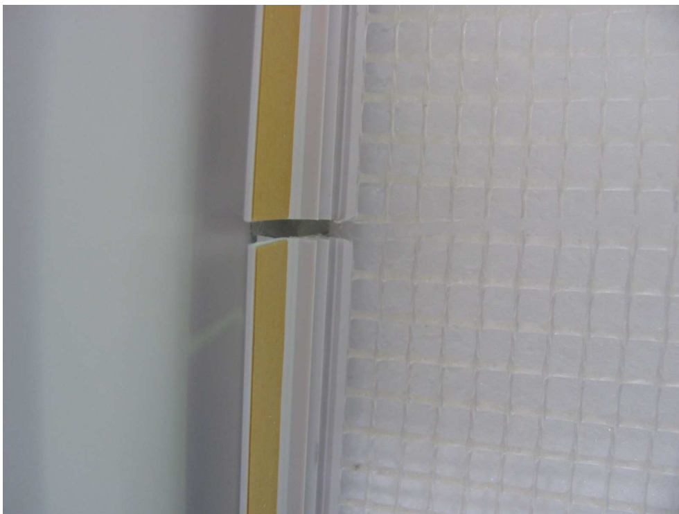
Bild 5 Detailansicht Stoß mit Gelband
