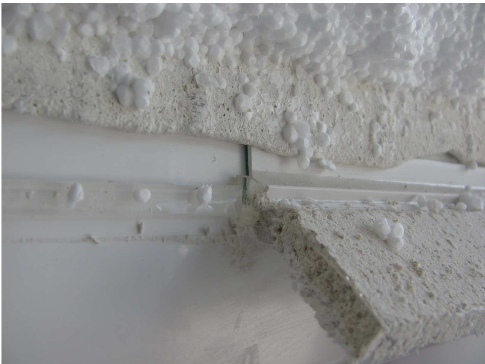
Bild 4 Anputzdichtleiste 3779G teilweise demontiert
