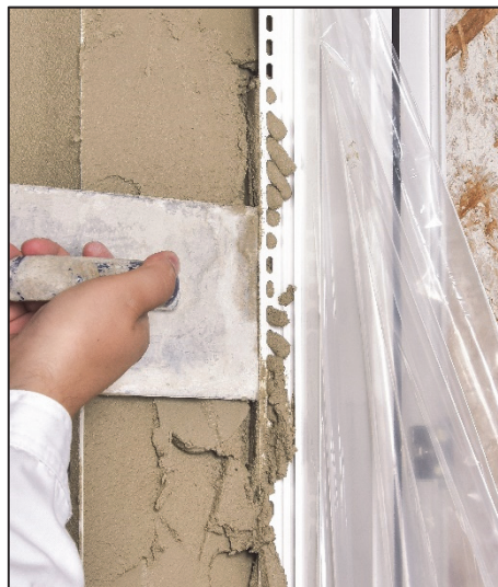
8. Profil vollständig in die Putzschicht einarbeiten!
