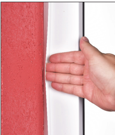
10. Nach Austrocknung des Oberputzes Abziehstreifen über die gesamte Länge einknicken.
