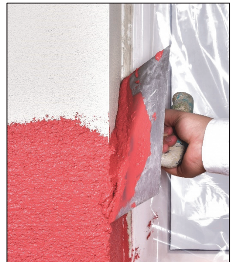
9. Nach Trocknungsphase – Oberputz auftragen.
