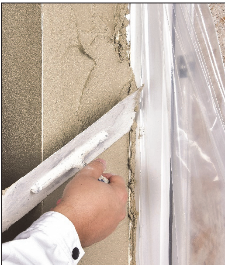
7. Grundputz auftragen. Abziehkante nutzen.
