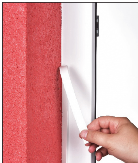
11. Abziehstreifen entfernen.
