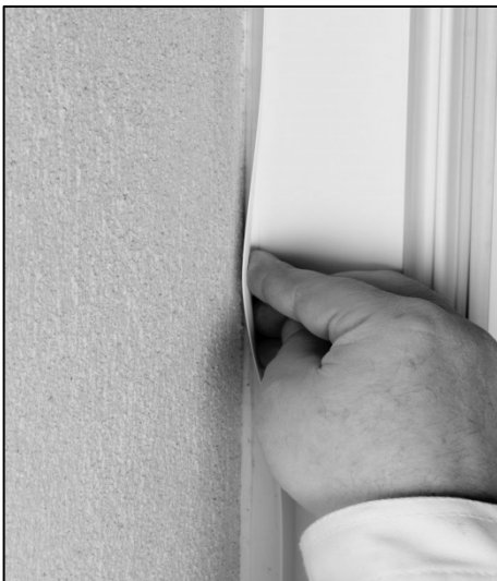
10. Nach Austrocknung des Putzes Abziehstreifen einknicken.
