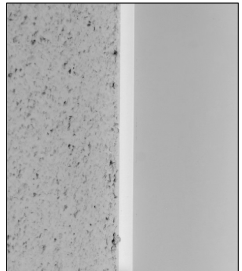
12. Perfekter Putzanschluss. (Darstellung mit Lippe)
